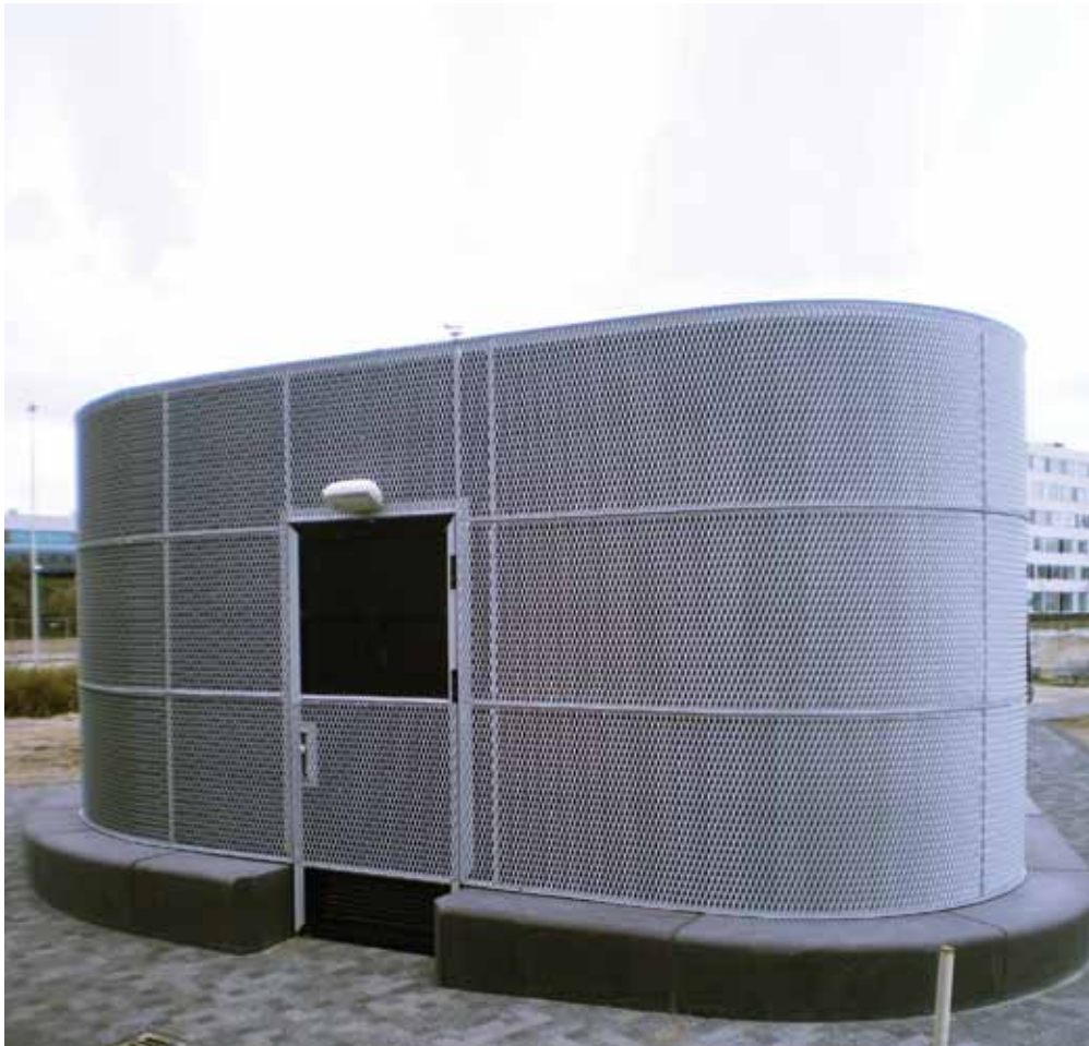
Design transformatorstation met strekmetaal.
